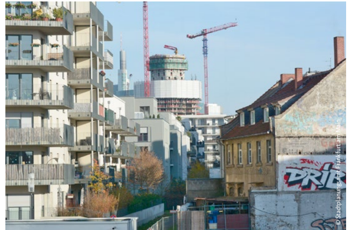
Blick zur Baustelle des Wohnhochhaus „GRAND Tower“
