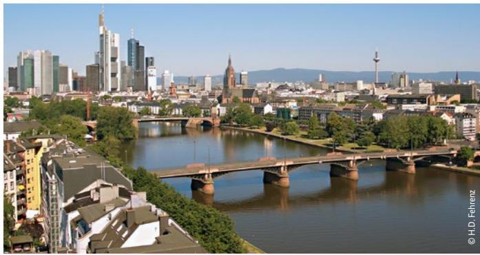
Mainbrücken vor Frankfurter Skyline
