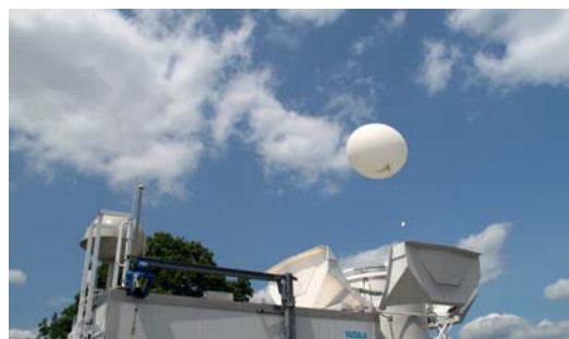
Automatische Station zum Starten von Radiosonden
