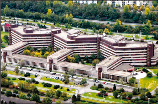
Die Liegenschaft des BfV in Köln.
