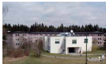
Hörsaalgebäude in Fürstenfeldbruck/ Bayern, dahinter Teil des Gästehauses
