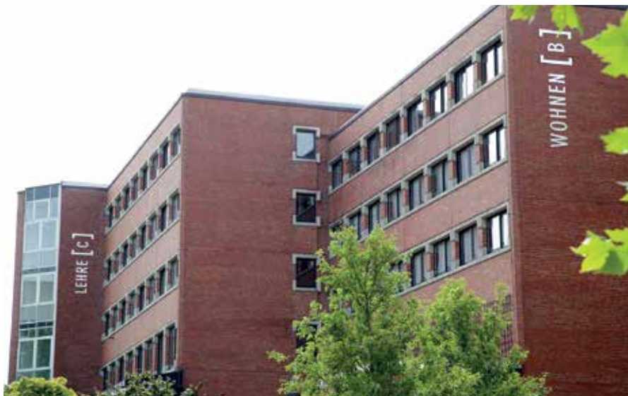
Neue Liegenschaft Mecklenbecker Straße in Münster
